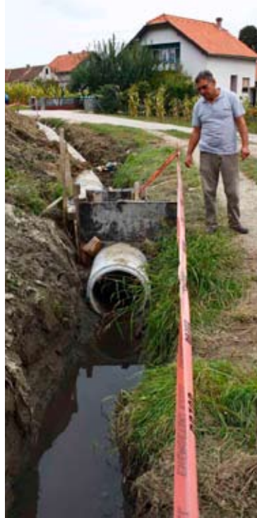
Cijevi za oborinske vode postavljene su i na izlazu iz Vrhovca, prema poljskim putovima
