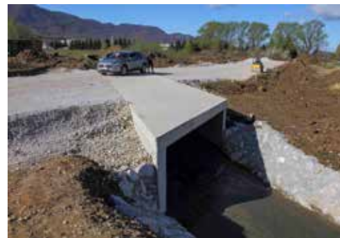
Do gradilišta je probijena nova makadamska cesta, a njoj je sagrađen je most preko Matačine dug 27 i širok 4 m
