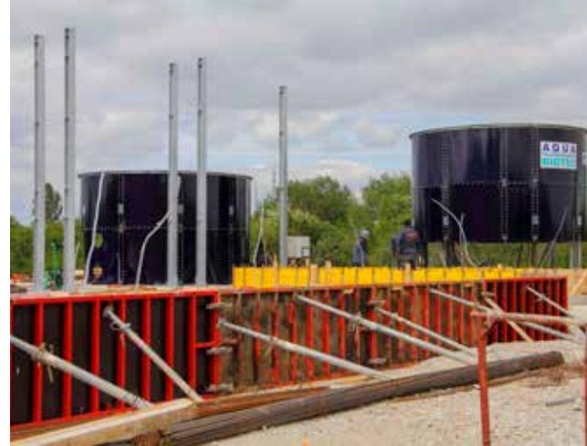
Podižu se specijalni silosi za denitrifikaciju otpadnih voda
