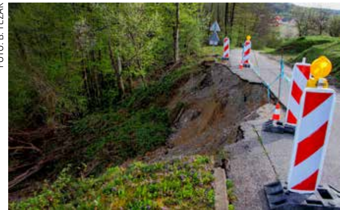
Klizište je u dubinu odnijelo 15-ak metara ceste
