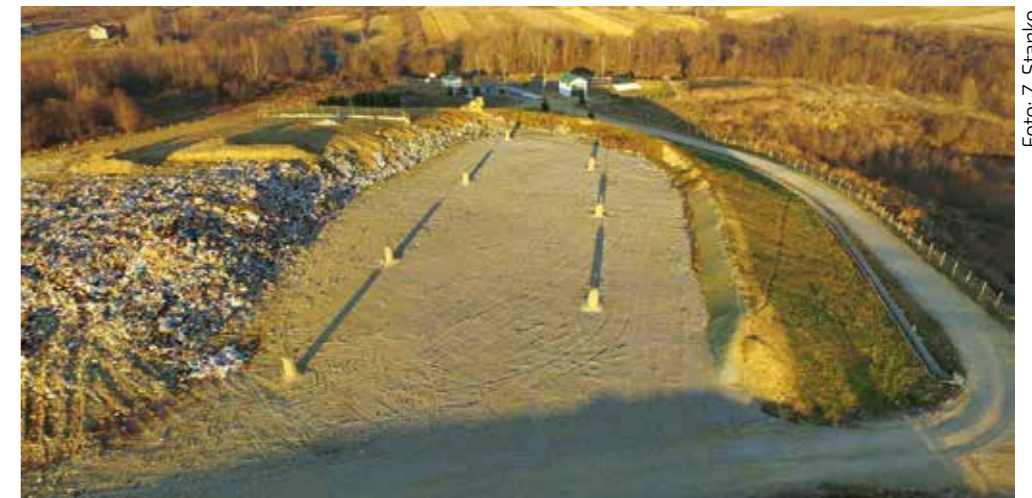
Država želi nastavak odlaganja otpada u Jerovcu najmanje do 2028., tako da se opet otvori već zatvorena i sanirana kazeta iz više razloga.
