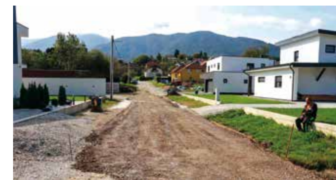
Pripreme za asfaltiranje Ul. Josipa Kraša
