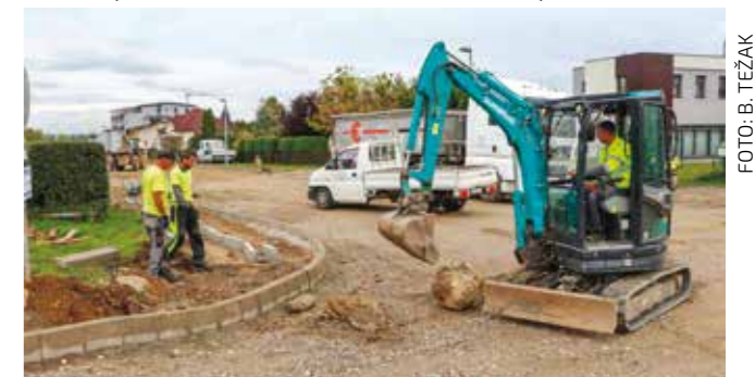
Rekonstrukcijski radovi na južnom dijelu Gunduličeve ulice
