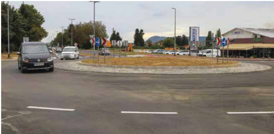
Gradnjom novog rotora riješeno je kritično raskrižje Gundulićeva-Kovačičeva, ali ne zaslugom Hrvatskih cesta
