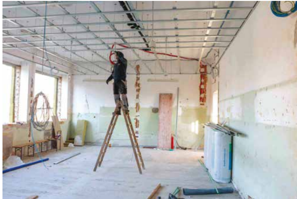
Izvedba instalaterskih radova
