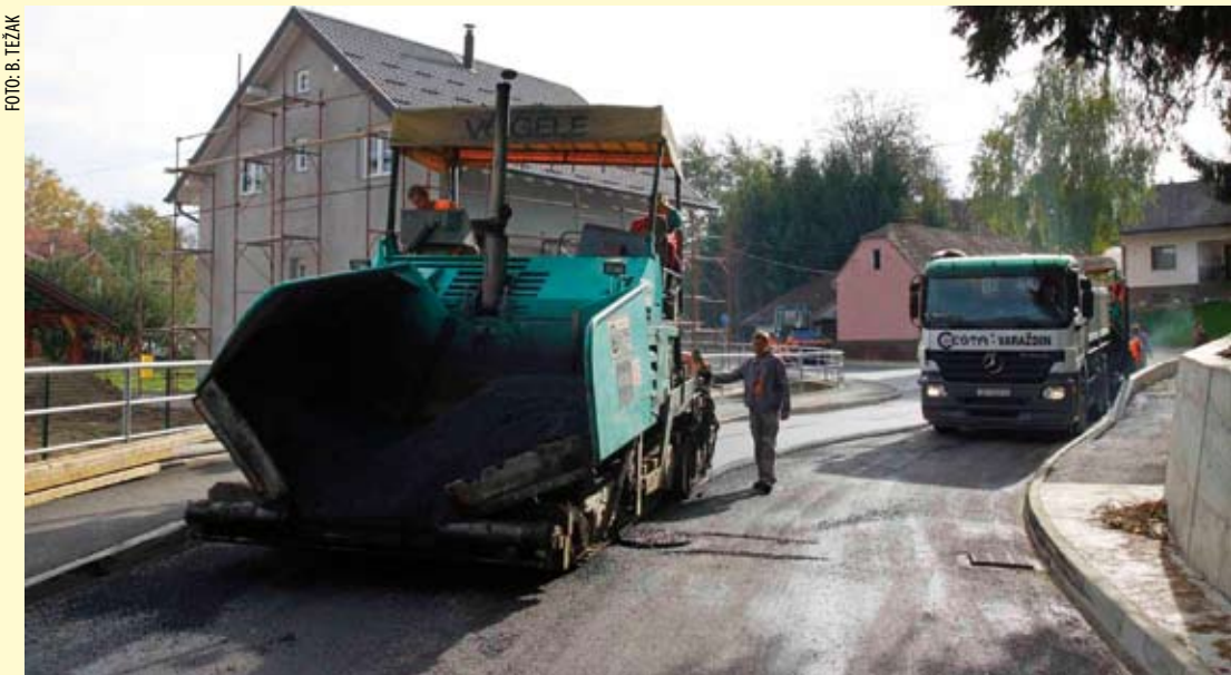
Polaganjem finog asfaltnog sloja, Cesta Varaždin je završila s radovima na gradnji zahtjevnog spoja Rajterova-Malezova
