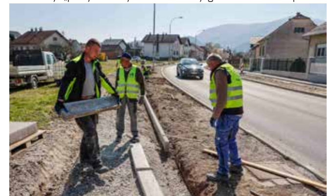
Najprije postavljanje rubnjaka za nogostup na cijelom potezu od Kolodvorske do špice
