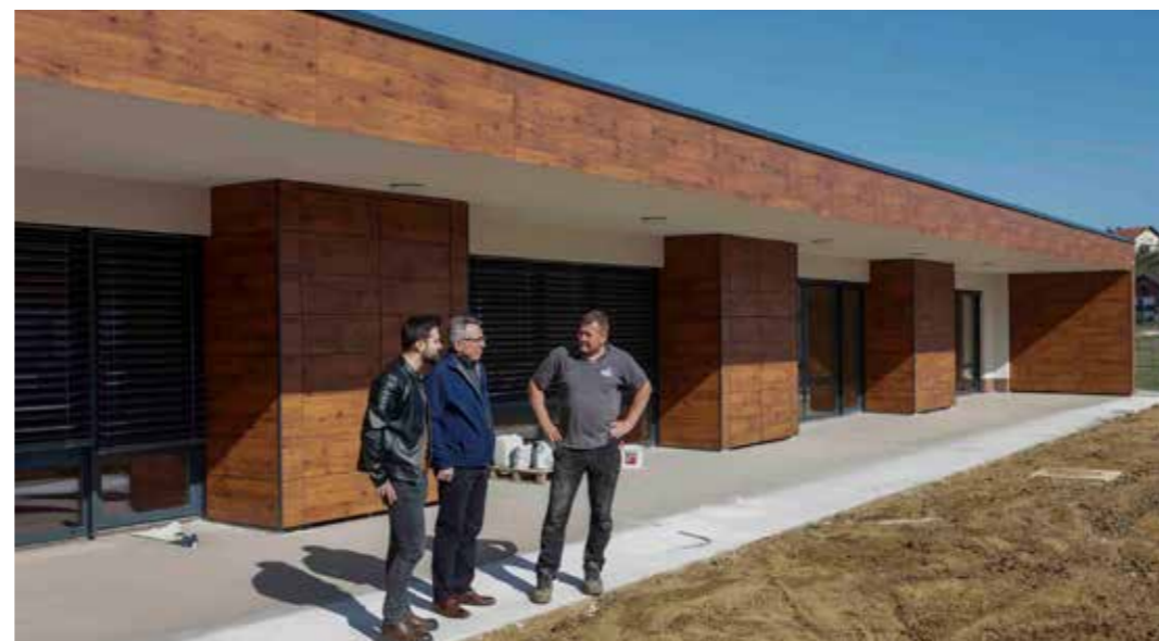
Novi objekt vrtića građevinski je potpuno dovršen, u tijeku je opremanje
