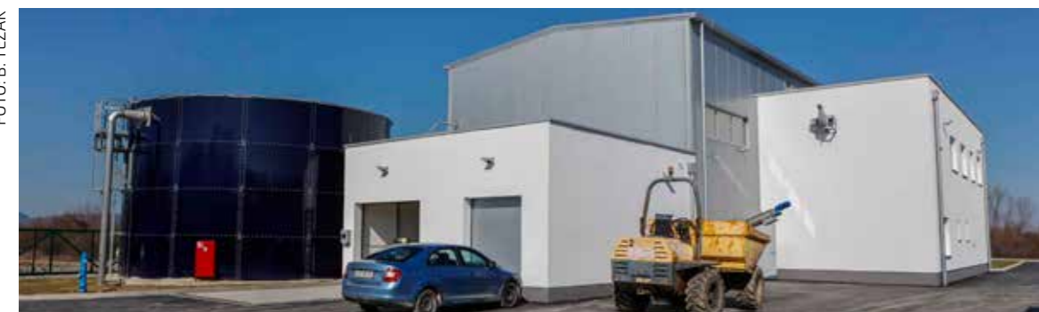
Završeni svi radovi na modernom pročišćivaču otpadnih voda u Ivanecu
