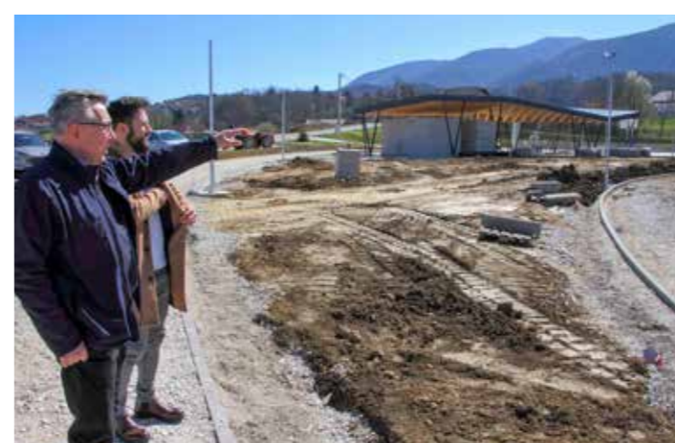
Gradski čelnici zadovoljni napredovanjem radova, bit će to sjajan sportsko-rekreativski kompleks
