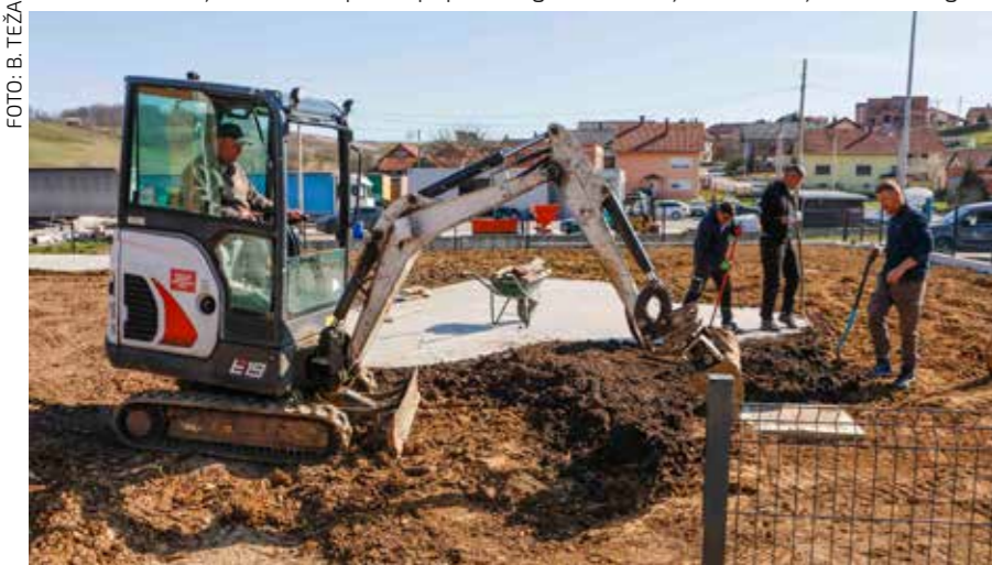
Betoniranje podloga za vlakčić, vrtuljak, ljuljačke, njihalice, klatilice
