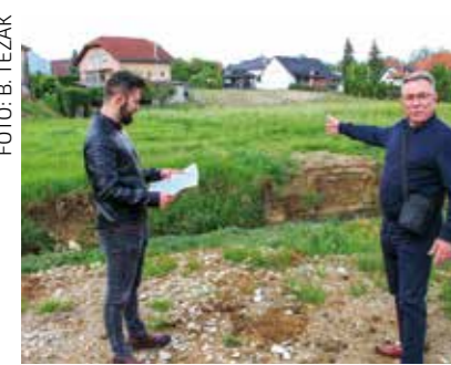
Ovdje kreće gradnja mosta preko Bistrice i nove ceste, spoja do Gajeve
