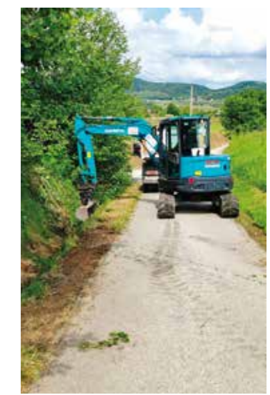
Očišćeno 300 m kanala u Seljancu
