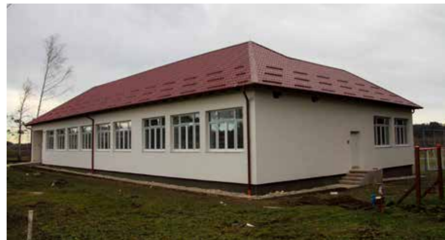
Zgrada u završnoj fazi, stiže i solarna elektrana
