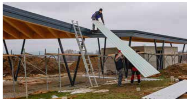
Završni radovi na pokrivanju nadstrešnice
