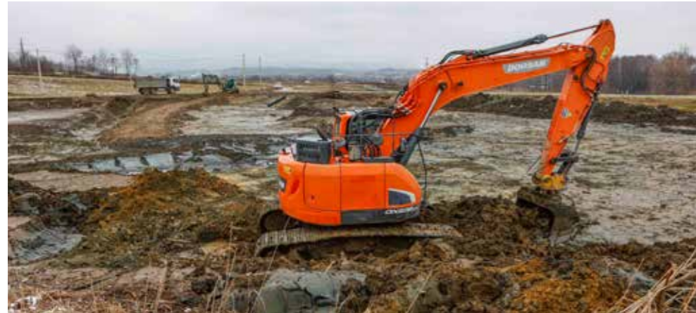
Izmulljivanje oko 5.000 m 3 mulja iz bajera u punome jeku
