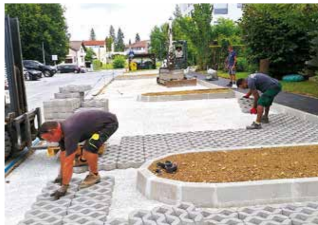
Postavljanje „zelenih rešetki“
