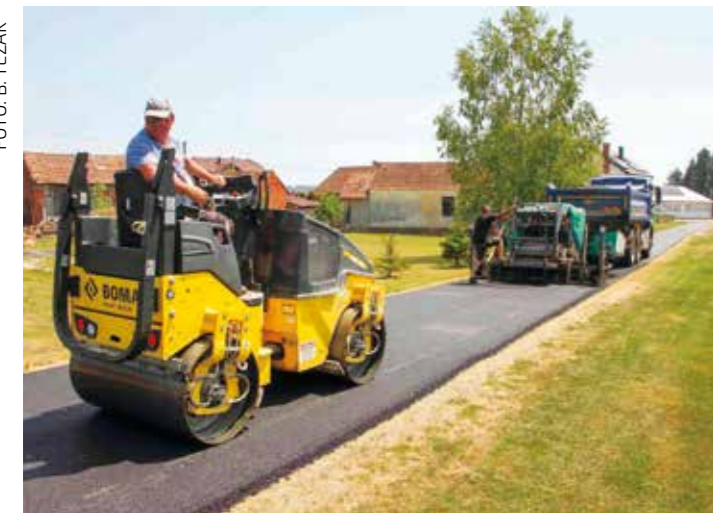
Asfaltiranje dionice pokraj nogometnog igrališta u Salinovcu
