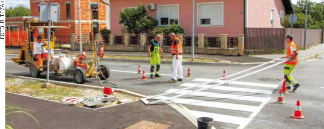
Nakon asfaltiranja, ulica je iscrtna propisano signalizacijom
