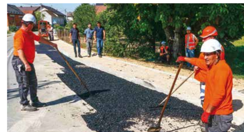
Asfaltiranje autobusnog stajališta i nogostupa
