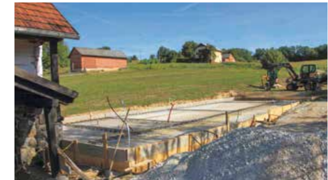
Pripreme za polaganje armiranobetonske ploče
