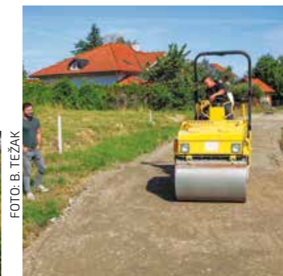
Gradnjom odvojka otvoren je prilaz novim građevinskim parcelama
