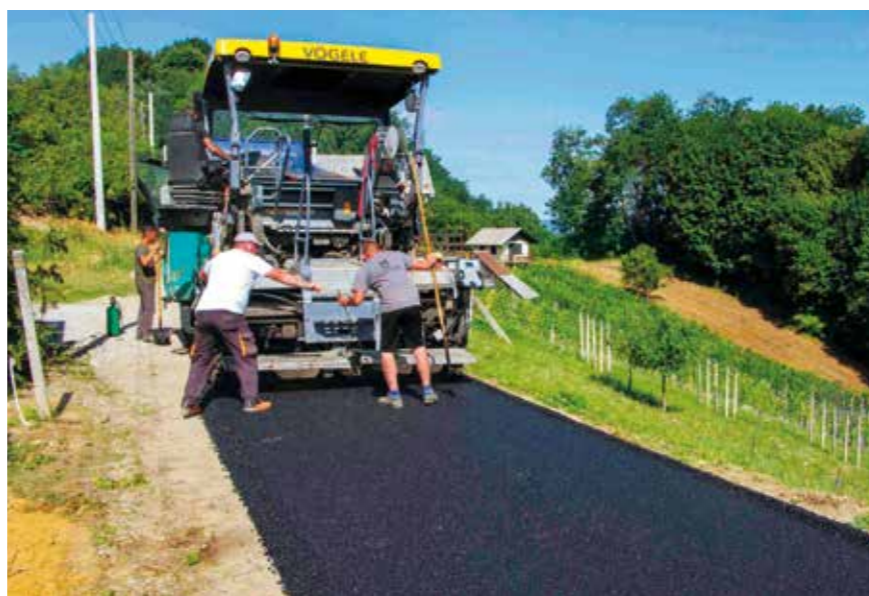
Asfalt je položen i na dionicu od stare preše na Šatornjaku prema zaselku Sokrižje
