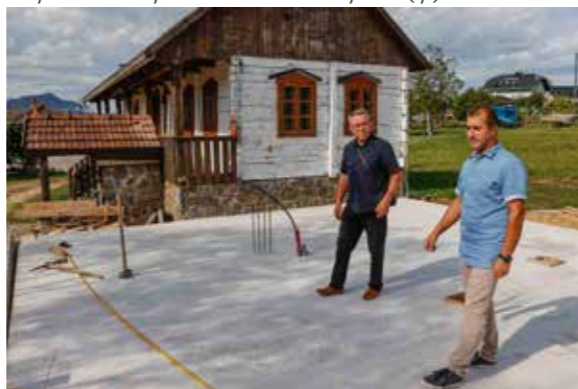
Temeljna ploča je položena, slijedi „dizanje“ objekta
