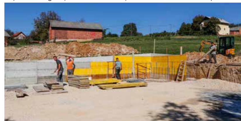
Oko objekta se gradi betonski parapet
