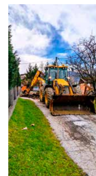
Uklanjanje dođerana asfalta odvojku Kukuljevićeve ulice
