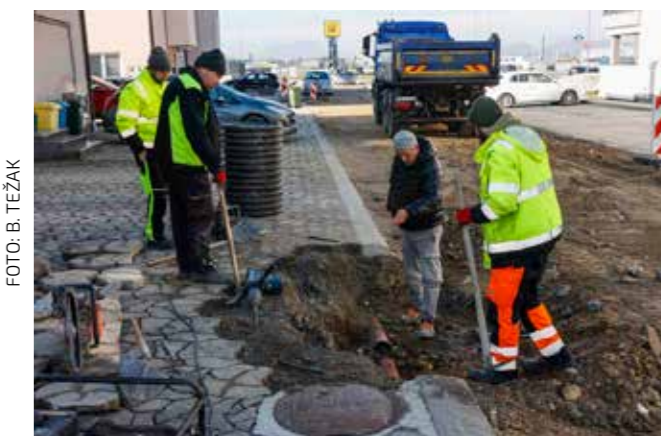
Grad rješava i zatečene probleme s odvodnjom kod zgrada u Ivanečkome Naselju
