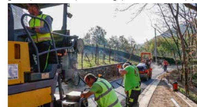
Asfaltiranje ceste nakon završetka sanacijskih radova
