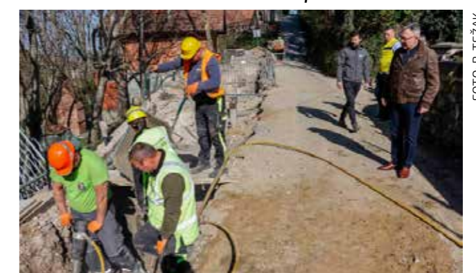
Gradski čelnici u obilasku radilišta
