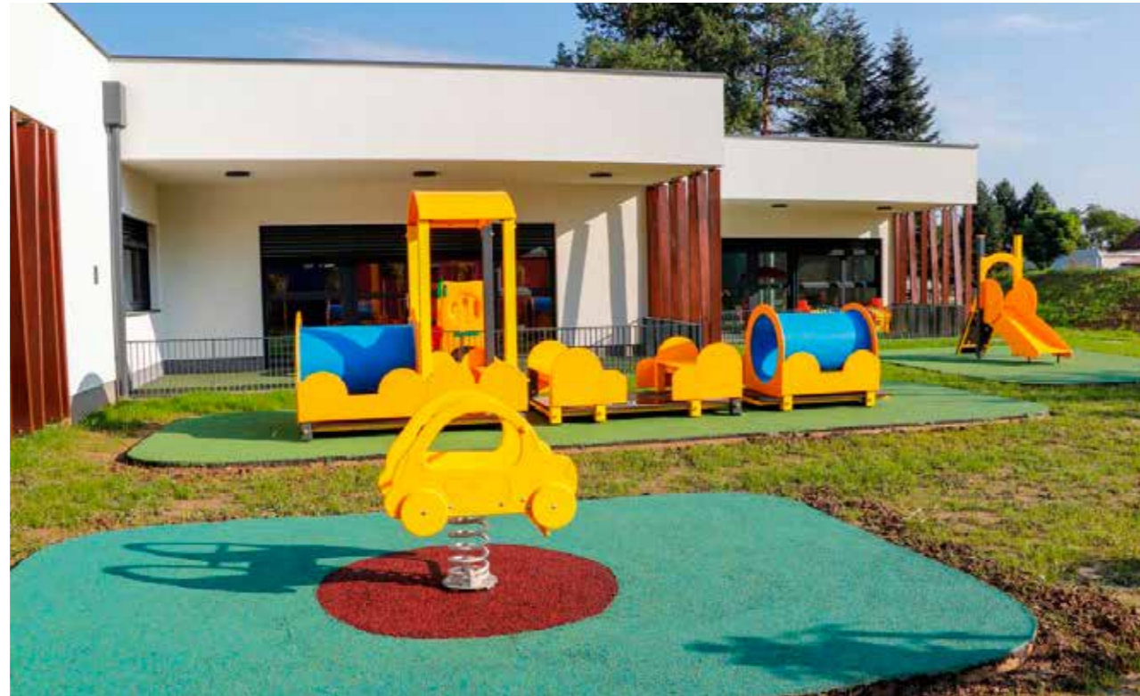
Dogradnja postojećeg vrtića više nije moguća zbog zakonskih ograničenja
