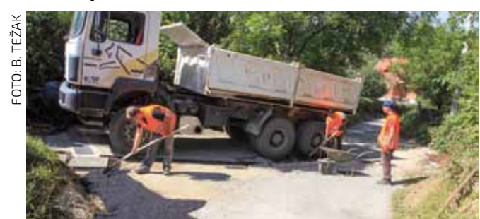
Nakon izvedenih radova, površine su sanirane i presvučene novim asfaltnim slojem
