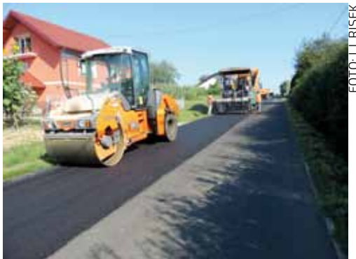
Polaganjem novog asfaltnog sloja uvelike je povećana sigurnost na dijelu ceste na kojem vozači rado „nabiju“ gas
