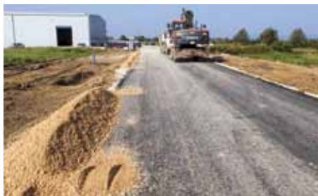
Cesta je asfaltirana, izvršene su pripreme za postavljanje stupova javne rasvjete
