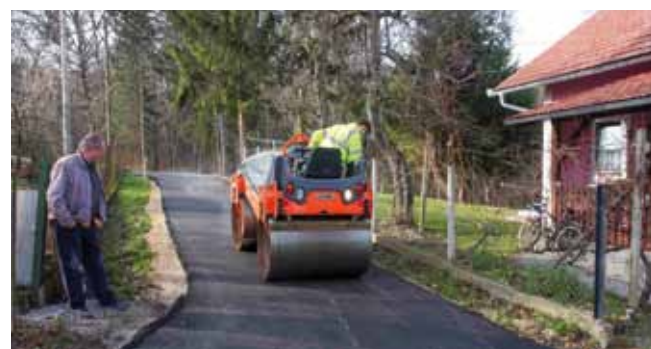
Asfaltiranje produžetka odvojka u Hunjetima u MO-u Horvatsko
