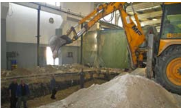
U tvornici obavljaju radove za uzemljenje strojeva velikih dimenzija
