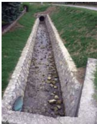
Kamenom su obložene i od erozije zaštićene stranice potoka Bistrice u Ivancu
