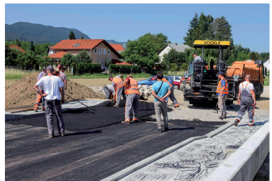
Polaganje asfalta na novosagrađeni most
