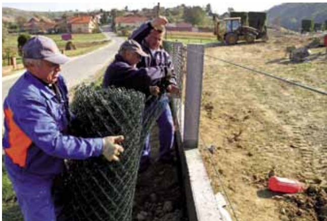
Radnici su postavili plastificiranu žičanu ogradu
