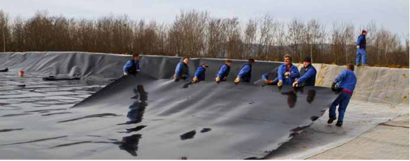
Geotekstilom i umjetnim folijama prekriveno je cijelo dno kazete površine 4500 „kvadrata“
