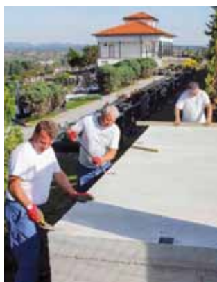
Na svim grobljima izgrađeni su betonski podestzi za kontejnere, a slijedi i postavljanje ograda oko njih
