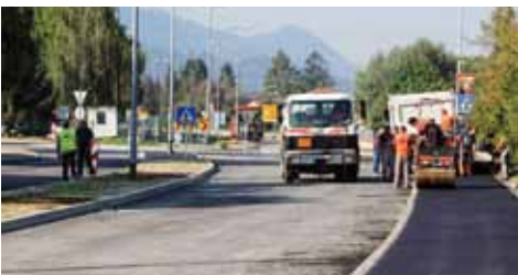
Završni radovi na asfaltiranju staza i uređenju kontaktnih površina rotora
