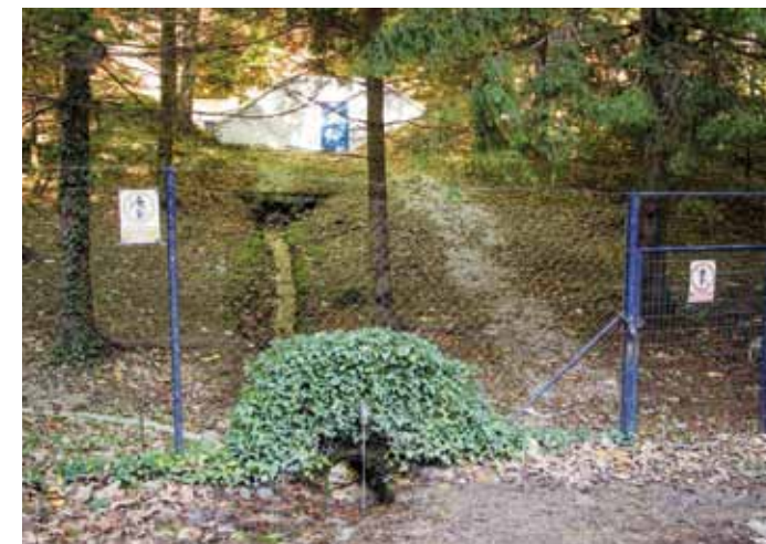
Sa Žganog vina (izvorište s kaptažom 15 l/s) na n. v. 430 m, voda se cjevovodom doprema u vodospremnik Pahinsko
