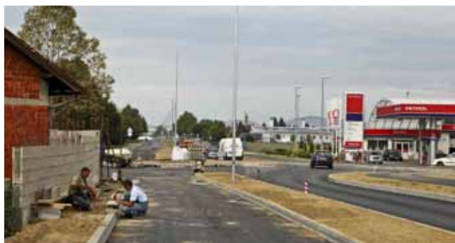
Radovi u završnoj fazi, na dijelu dionice uz privatni stambeni objekt podiže se ograda protiv buke
