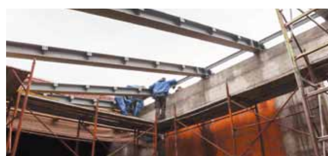
Postavlja se metalna konstrukcija za pokrov
