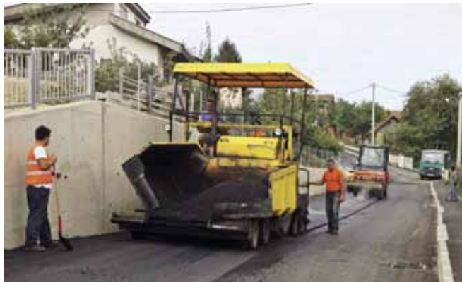
Polaganje finog asfaltnog sloja u Lančiću
