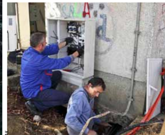
Djelatnici Elektre premještaju sustave za upravljanje rasvjetom iz svojih trafostanica u gradske ormariće
