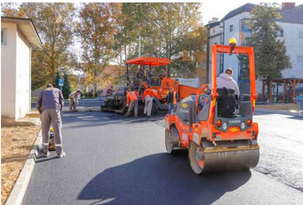
Polaganje finog asfaltnog sloja na novo parkiralište i pristupnu cestu
