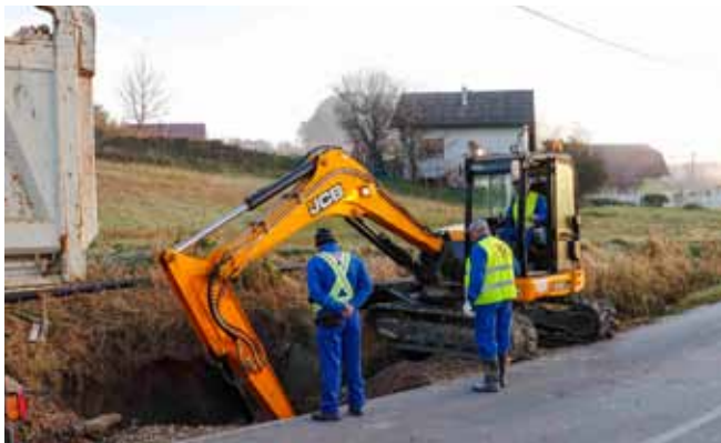
Uz kanalizaciju, polažu se i cijevi za oborinsku odvodnju
