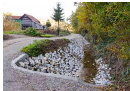
Novouređen cijevni propust i kvalitetni pristupni put: Zajednička investicija Hrvatskih voda i Grada
