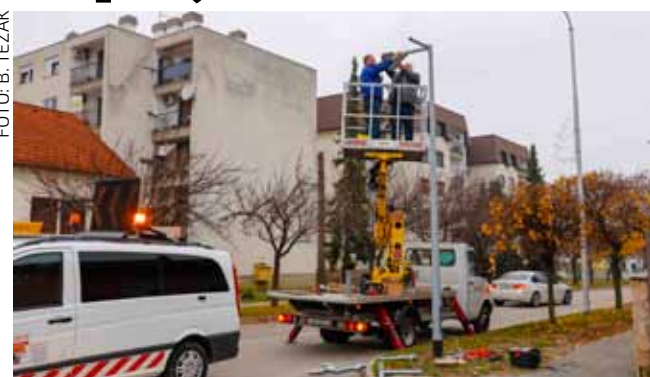
Montaža LED rasvjetnih tijela na stupove na raskrižju Nazorova – Gajeva ulica
