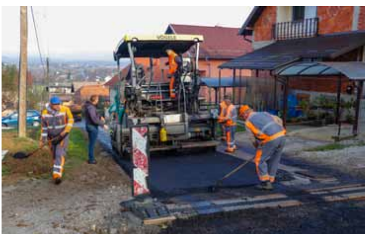
Mihanovićeve ulica cjelovito će biti uređena nakon završetka aglomeracijskih radova, kada će se u njoj izgraditi nogostup, urediti oborinska odvodnja i položiti novi asfaltni kolnik
