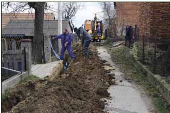
U prvoj fazi polaže se 1700 metara razvodne mreže do kuća koje nisu bile spojene na Ivkomov sustav
