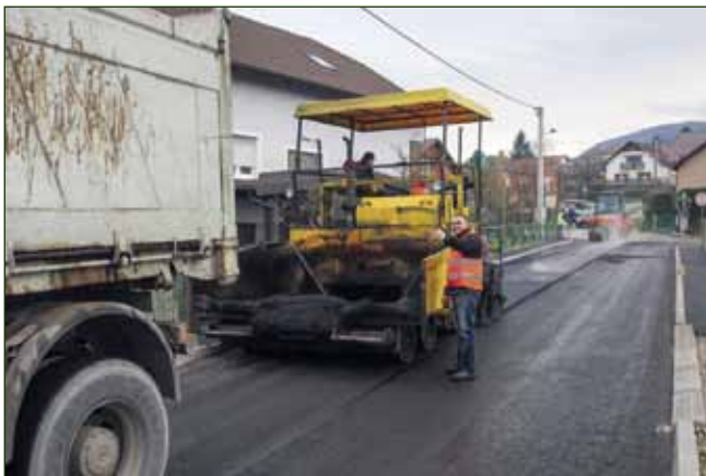
Povoljno vrijeme iskorišteno je za polaganje finog asfaltnog sloja
