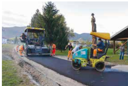
Polaganje asfalta u odvoju Malezove prema Ribičkom domu
